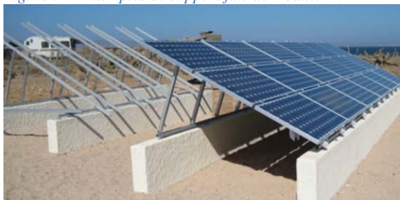
Figure 30 : Exemples de support fixe de module PV
