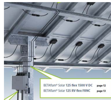
Figure 32 : String avec modules et boîtier de raccordement
