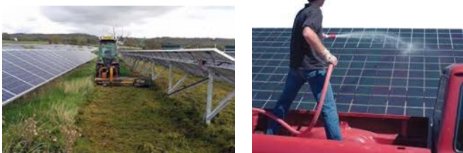
Figure 45 : Les différents aspects de la maintenance
