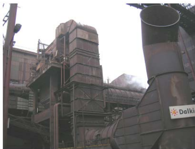
Prise d'énergie sur la chaîne d'agglomération Arcelor-Mittal
