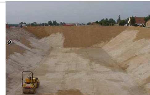
Construction du stockage de 75 000 m 3
