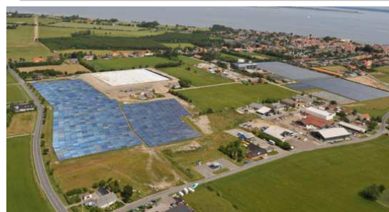
Réseau de chaleur de Marstal : collecteur thermique
